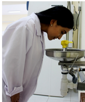
"Lavaojos" en Laboratorio de Química.
